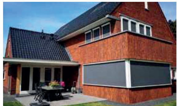
Donkergrijze windvaste screens op de begane grond en eerste etage van een woonhuis.
